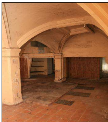
Anciennes cuisines au sous-sol
